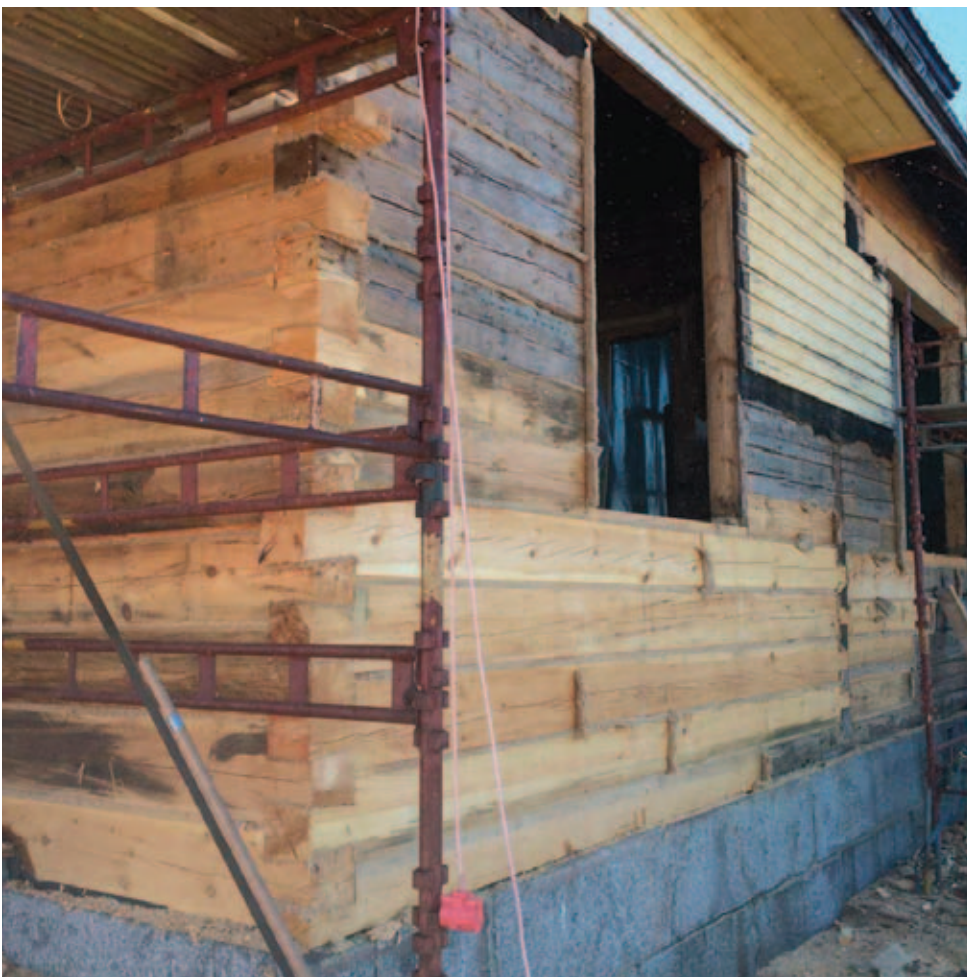
70 meter timmer senare, de ruttna stockarna är ersatta av nya (foto Arne Nieland)
