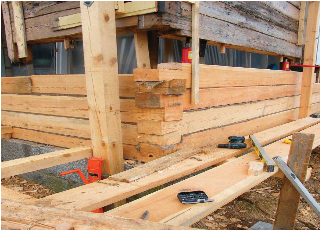
Sydöstra hörnet byggs upp. (foto Jonas Lindvik)
