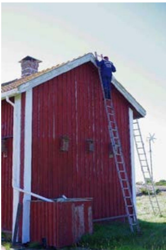
Gubbar uppåt väggarna: Antti T. fixar vattbrädan på norra sidan © JE
